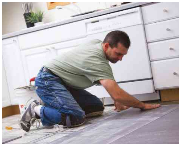
Colocação de pisos.
