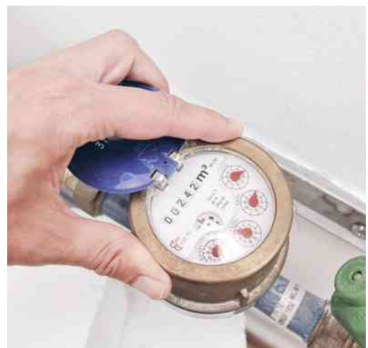
Hidrômetro, aparelho que mede o consumo de água nos imóveis.
