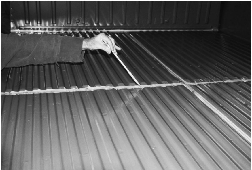
Figura 84 Aplicação, por pincelamento, de massa de vedação em juntas da carroceria
