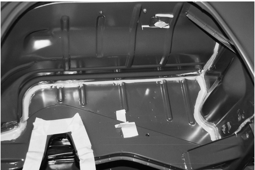
Figura 85 Interior do veículo após a aplicação da massa de vedação
