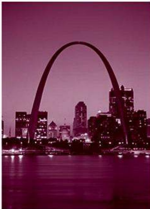
O projeto do Gateway Arch, em St. Louis, está baseado em uma curva invertida do cosseno hiperbólico.
